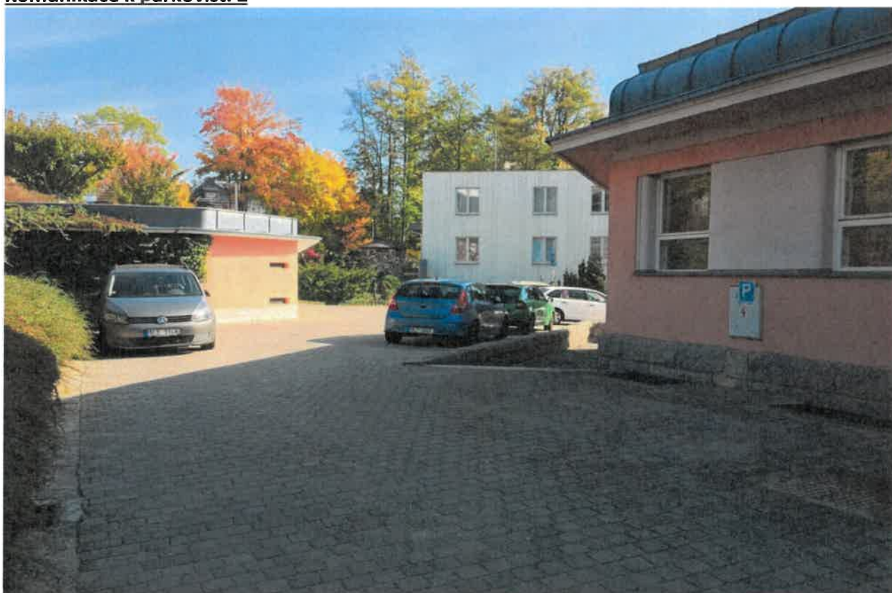
Komunikace k parkovišti 2
