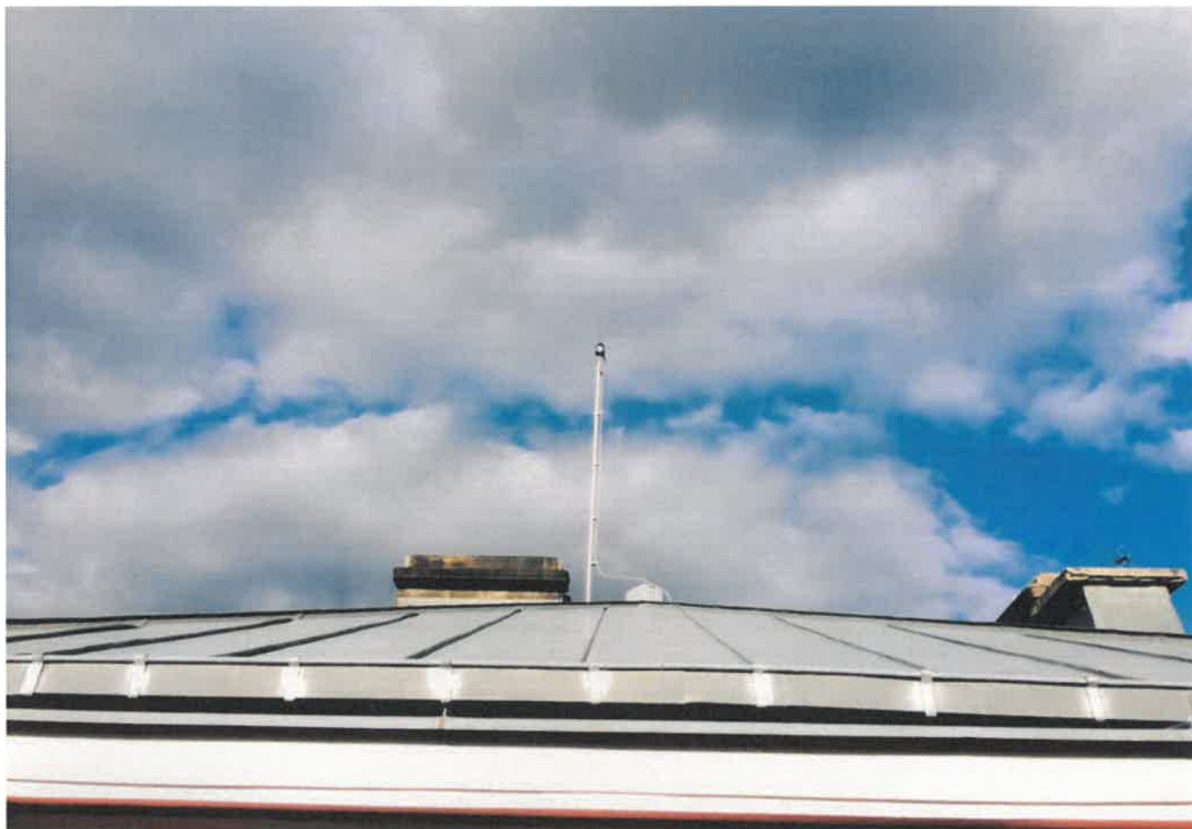
Hromosvodné vedení na střeše směrem ke svorce SZ a k uzemnění
