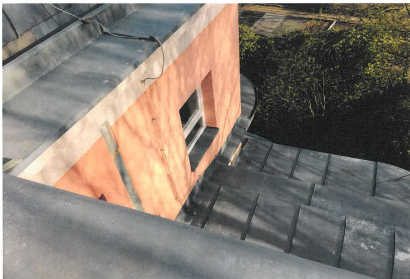
Hromosvodné vedení na střeše směrem ke svorce SZ a k uzemnění
